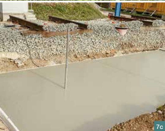
7 a), b), c) Postup realizácie penobetónu na skúšobnom poli ■ 7 a), b), c) Realization of the foam concrete in the experimental field
